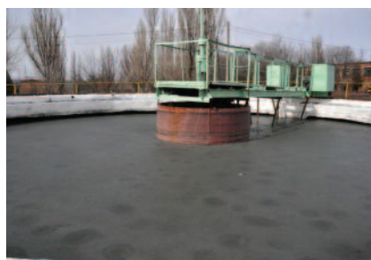
Рисунок 3. Флотационная установка с резервуаром отстойником
