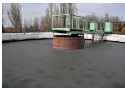
Рисунок 3. Флотационная установка с резервуаром отстойником
